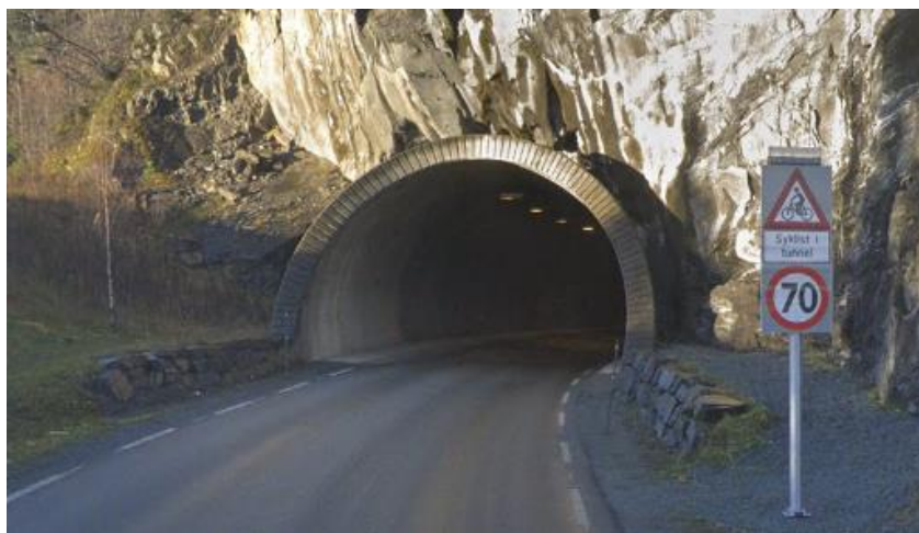
Figur 24: Sørlig tunnelportal på Frostaporten (Google maps)
