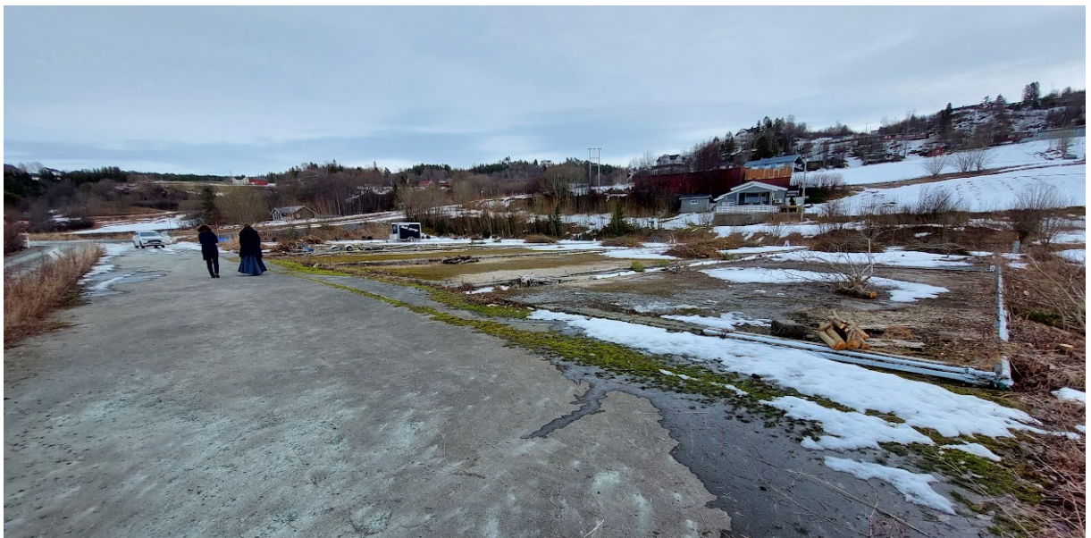
Over: Planområdet i mars 2022. Utsikt mot øst. Her ser man tydelig betongplatene som dekker det meste av planområdet. Ny innkjørsel til området er tenkt å komme gjennom vegetasjonen til venstre i bildet. Eier av hytten på bildet er en av de som har sendt inn merknad til planen. I nåværende plankart så vil det meste av arealet til høyre i bildet bli til arealformålet lek.
