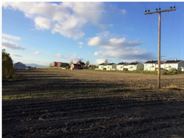
Bildet viser høgspenningslinje i luftlinje.
